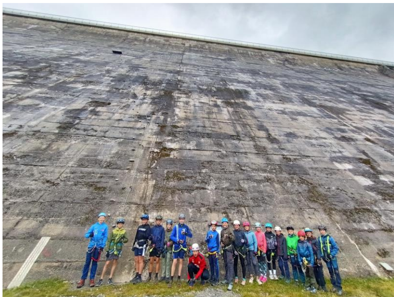
Abbildung 2: Klettern in der Staumauer-Wand war eine besondere Herausforderung
