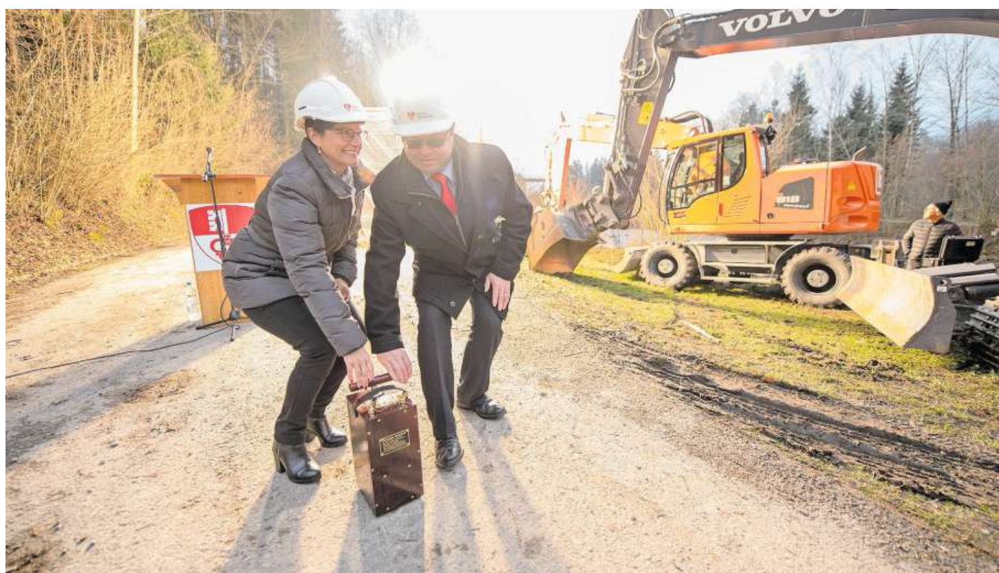
Die Regierungsräte Maya Büchi und Josef Hess eröffnen mit einer symbolischen ersten Sprengung die Bauarbeiten für den Hochwasserentlastungsstollen.
